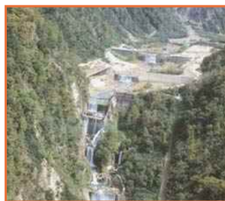
白岩砂防堰堤(富山県富山市・立山町)
