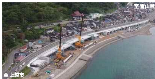
塩害により損傷が著しい橋梁の掛替(糸魚川市:国道8号 弁天大橋)
