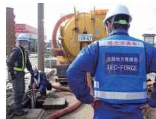
側溝清掃車による応急対策(長野県長野市)
