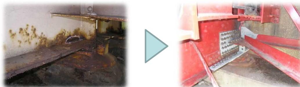
(支承部等の局所的な損傷に対するあて板補強例)
