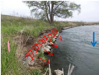
河岸を保護していた根固めブロックが流出したため、根固めブロックを投入
