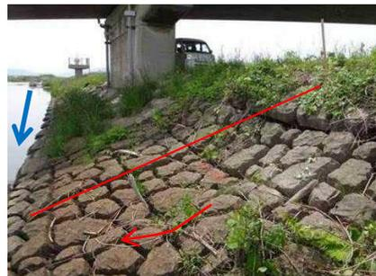
土砂が吸出され陥没した護岸を補修
