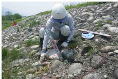
点検で護岸の空洞化が確認された箇所を補修
