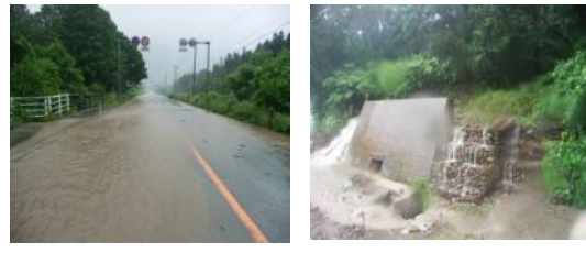
①被災状況(村上方面を望む) ②被災状況(山形方面を望む)
