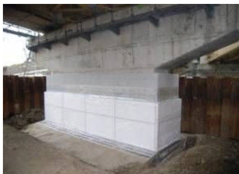
橋脚のコンクリート巻立て
