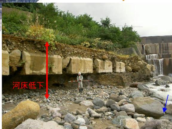
河床低下により既設護岸の根固めが浮いている
