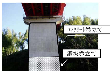
橋脚巻き立て箇所
