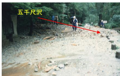
遊歩道に流出した土砂
