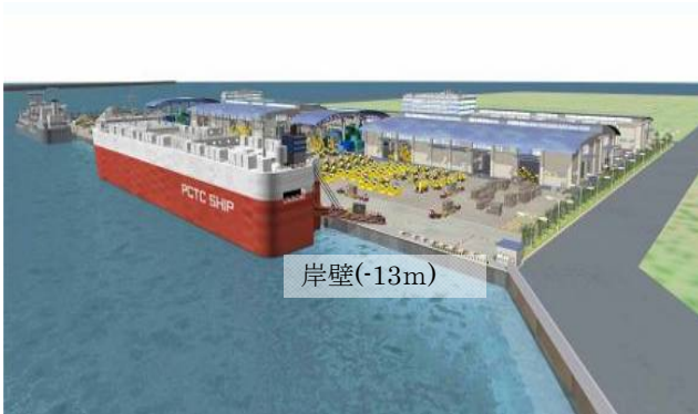
金沢港多目的国際ターミナルの整備（石川県）
