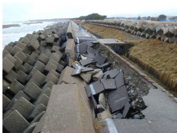
直轄下新川海岸の整備推進（富山県） 平成20年2月24日高波浪による被害状況
