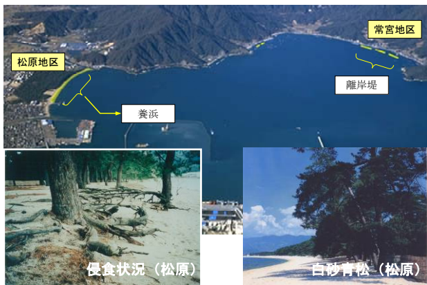
敦賀港海岸侵食対策事業(白砂青松、エココースト) の整備(福井県)
