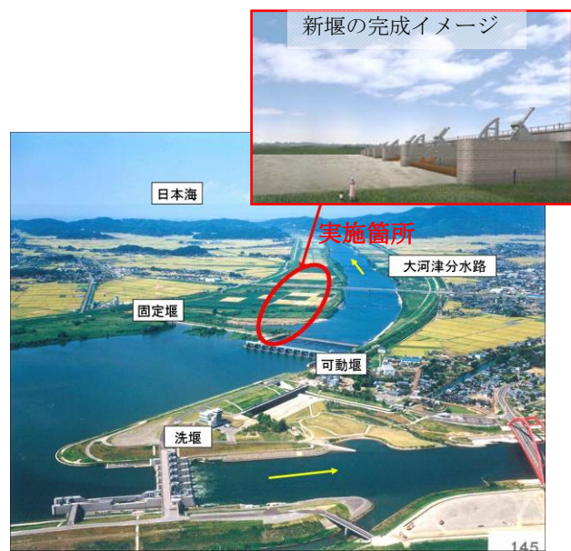
大河津可動堰改築事業（新潟県）
