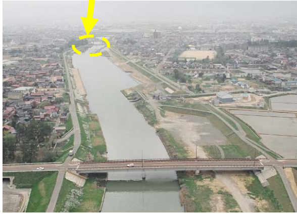
梯川重点区間改修事業（石川県）
