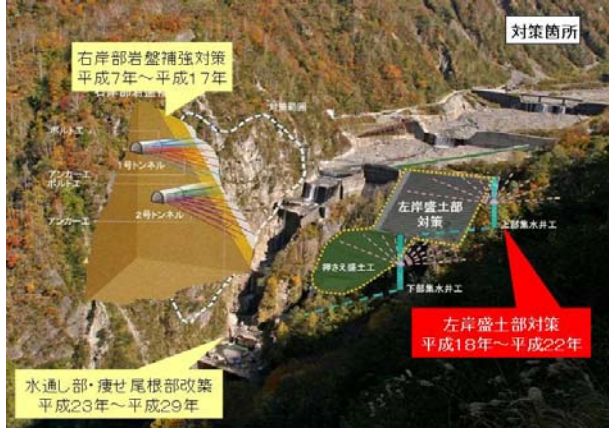
富山平野を守る白岩砂防えん堤保全対策工の整備（富山県）
