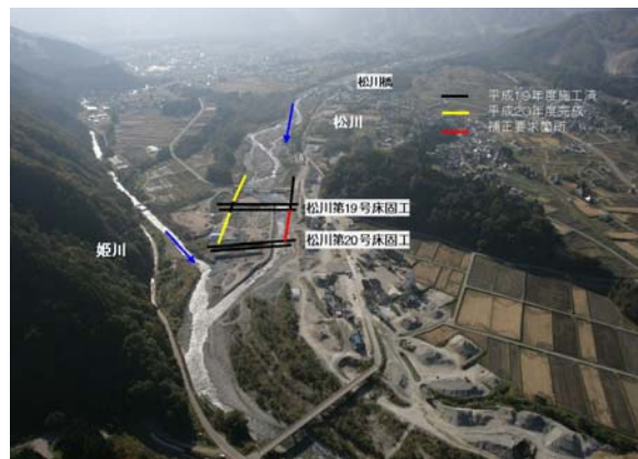
姫川大出床固工群
