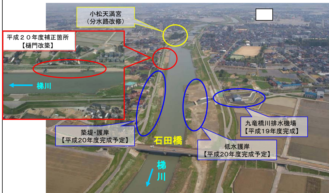
改修の進む梯川 (平成20年4月撮影)
