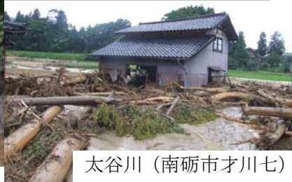
流木による下流域の被害状況
