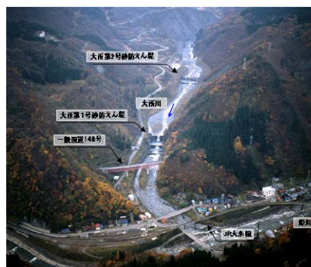
大所第1,2号砂防えん堤地点全景
