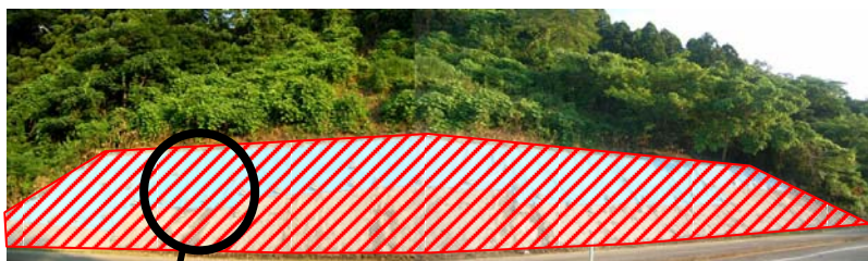
一般国道8号 南郷地区防災対策全景
