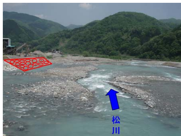
姫川大出床固工群施工箇所
