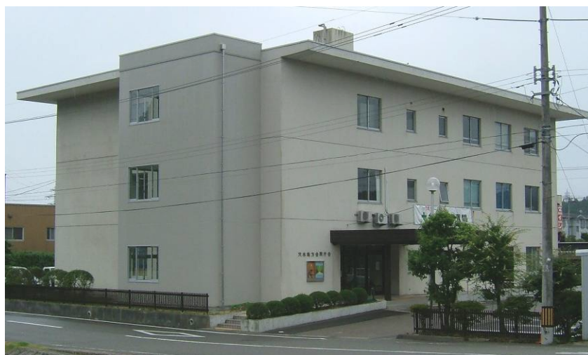
穴水地方合同庁舎 外観
