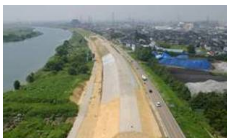
築堤（弱小堤対策）の整備状況
