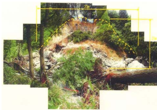
平成 17 年土砂崩落箇所
