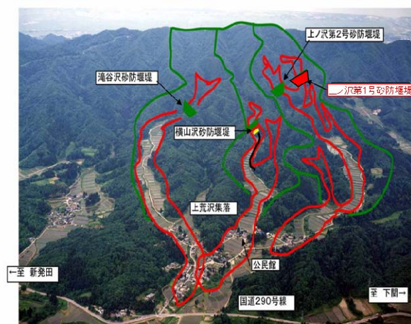
上荒沢砂防えん堤群
