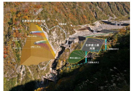
白岩砂防えん堤保全対策
