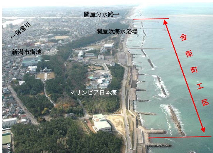
金衛町海岸の状況（平成15年10月）
