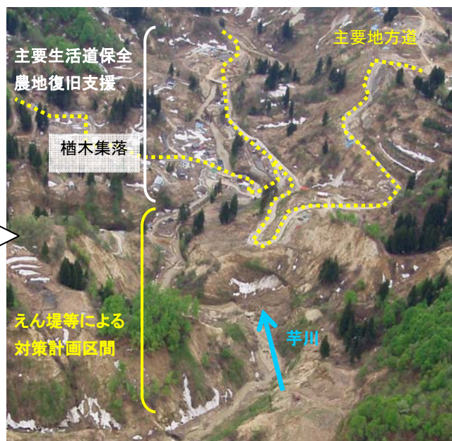
土砂流出の著しい南平下流地区
