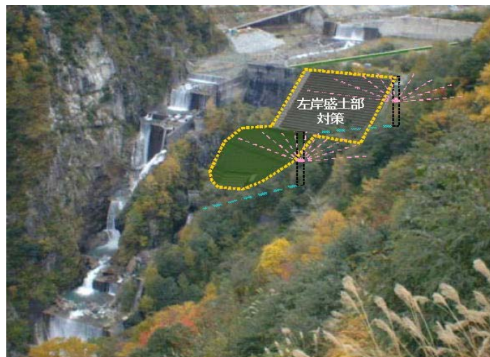
白岩砂防えん堤左岸盛土部補強対策
