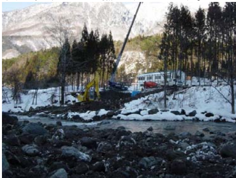
平湯川砂防樹林帯の施工状況
