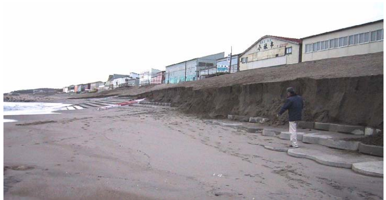
金衛町海岸被災状況（平成17年12月）
