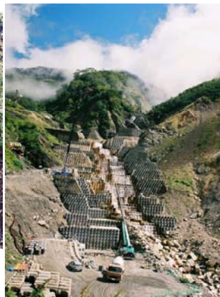
導流落差工の施工状況
