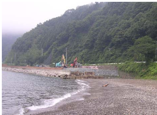
H19 部分供用に向けて工事が進む松ヶ崎地区
