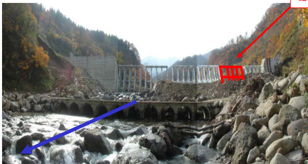
矢代川7号えん堤（下流側より望む）
