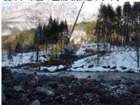
平湯川砂防樹林帯の施工状況
