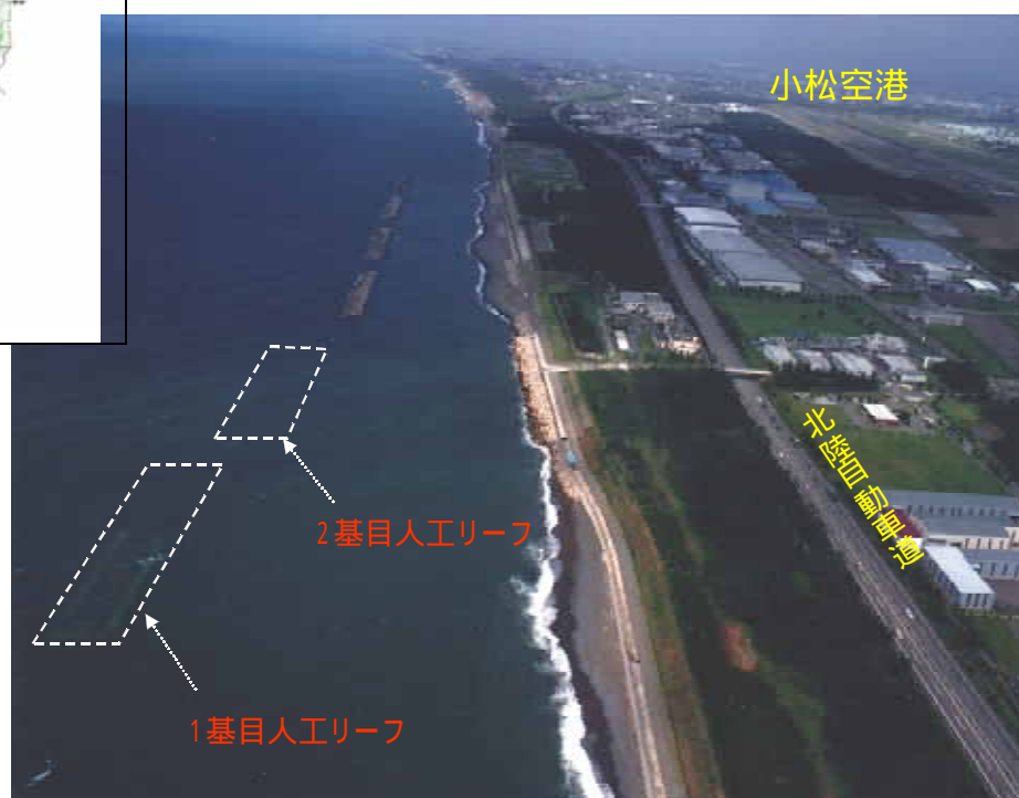
小松工区の状況（平成17年8月撮影）
