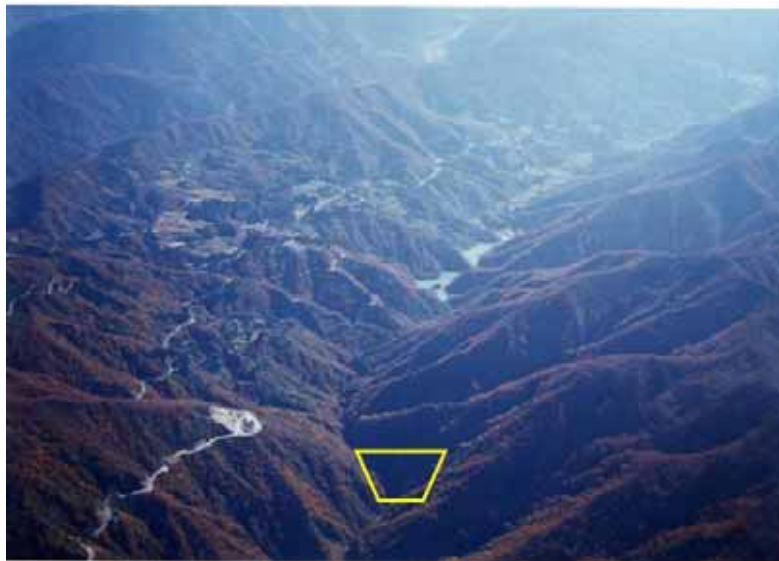
ダムサイトを下流より望む
