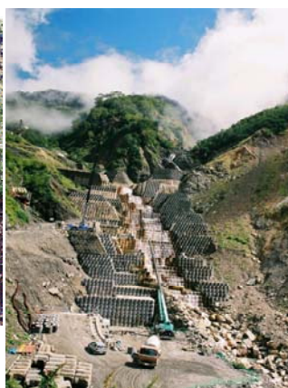
導流落差工の施工状況
