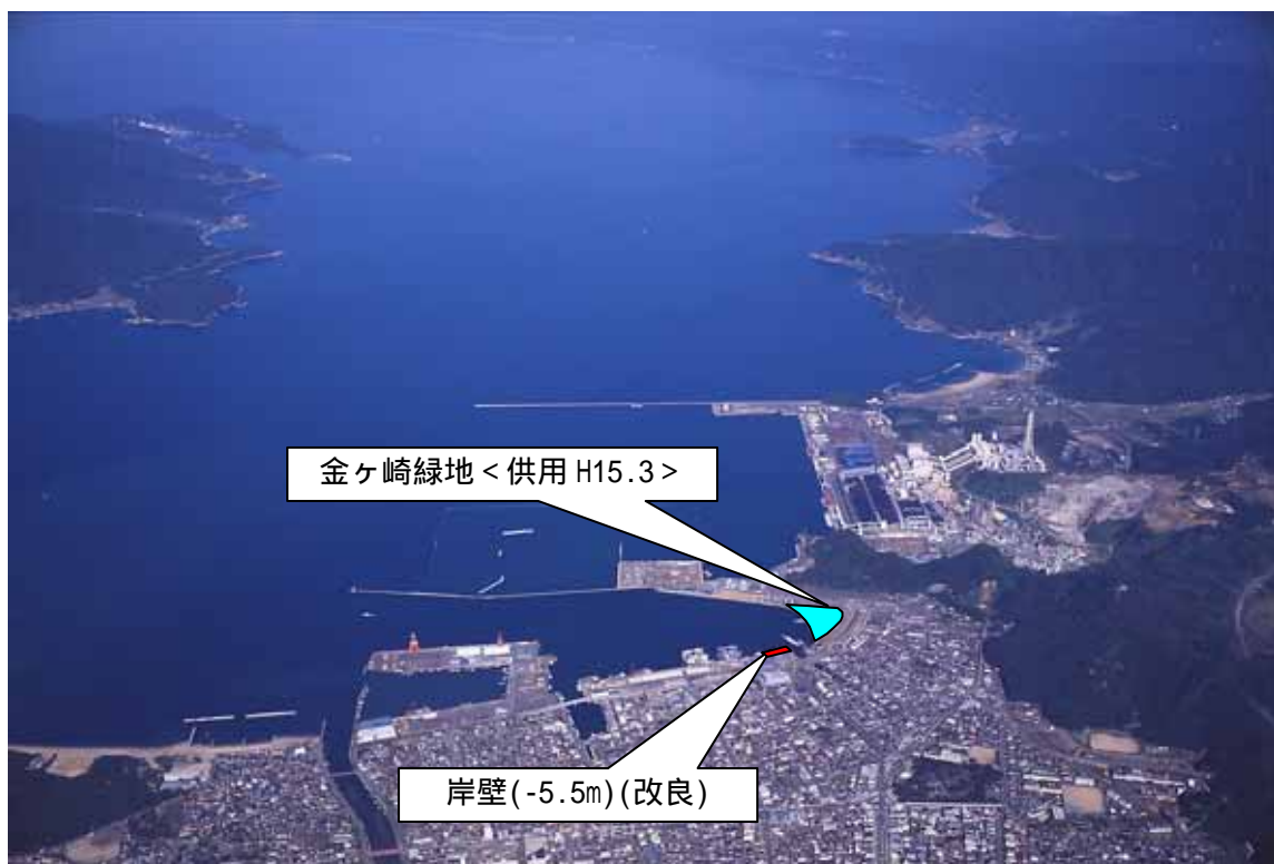
敦賀港の現況(平成 15 年 10 月撮影)
