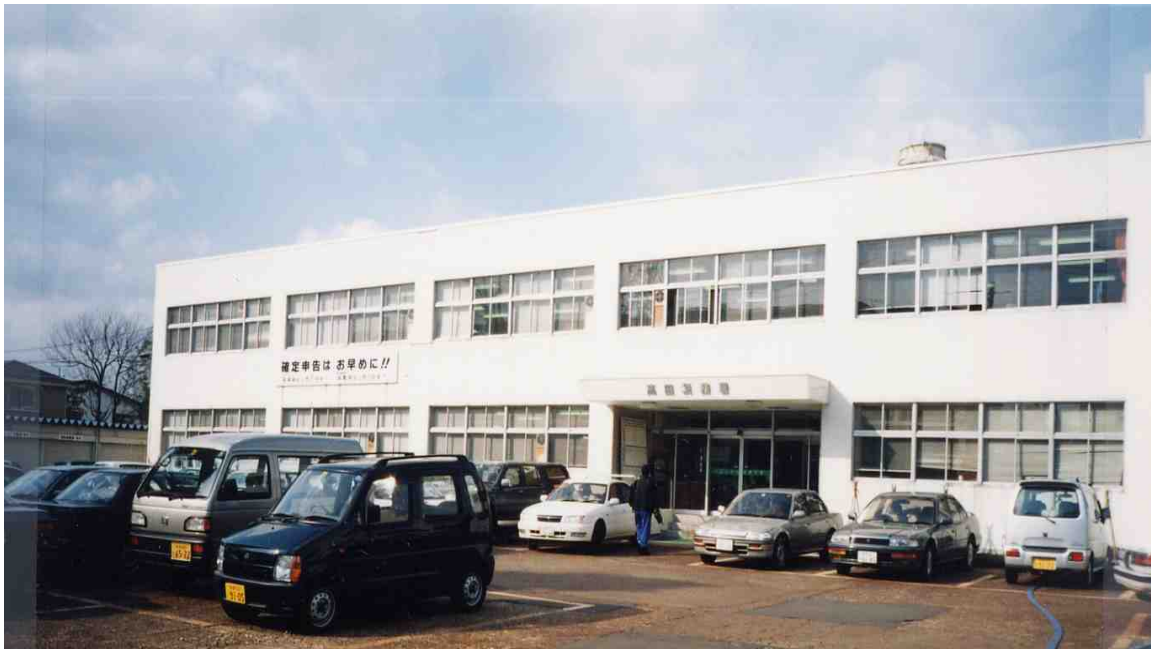
身体障害者対応エレベーターの設置を予定している高田税務署
