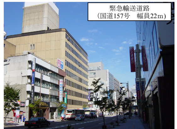
防災都市機能の強化を目的に緊急輸送道路 沿道の建築物の耐震改修を促進（石川県金沢市）
