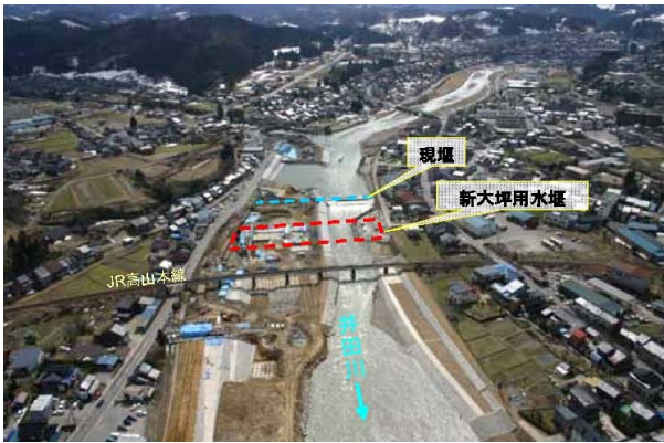
平成18年度の完成を目指し、事業を推進する 大坪用水堰改築事業（富山県富山市）
