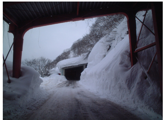
雪崩危険箇所の安全性を高める 一般国道405号防雪対策(新潟県津南町)
