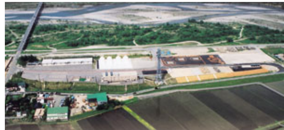
迅速な災害対応のための防災施設 (富山防災センター)
