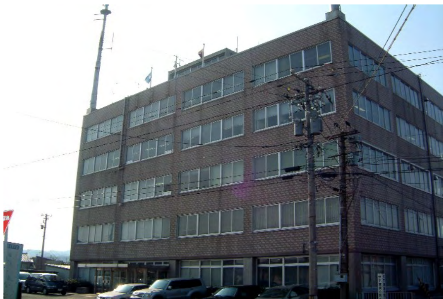
伏木港湾合同庁舎
