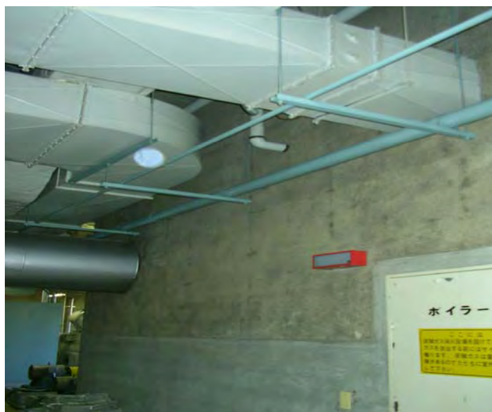
機械室（吹付けアスベストの除去を実施）
