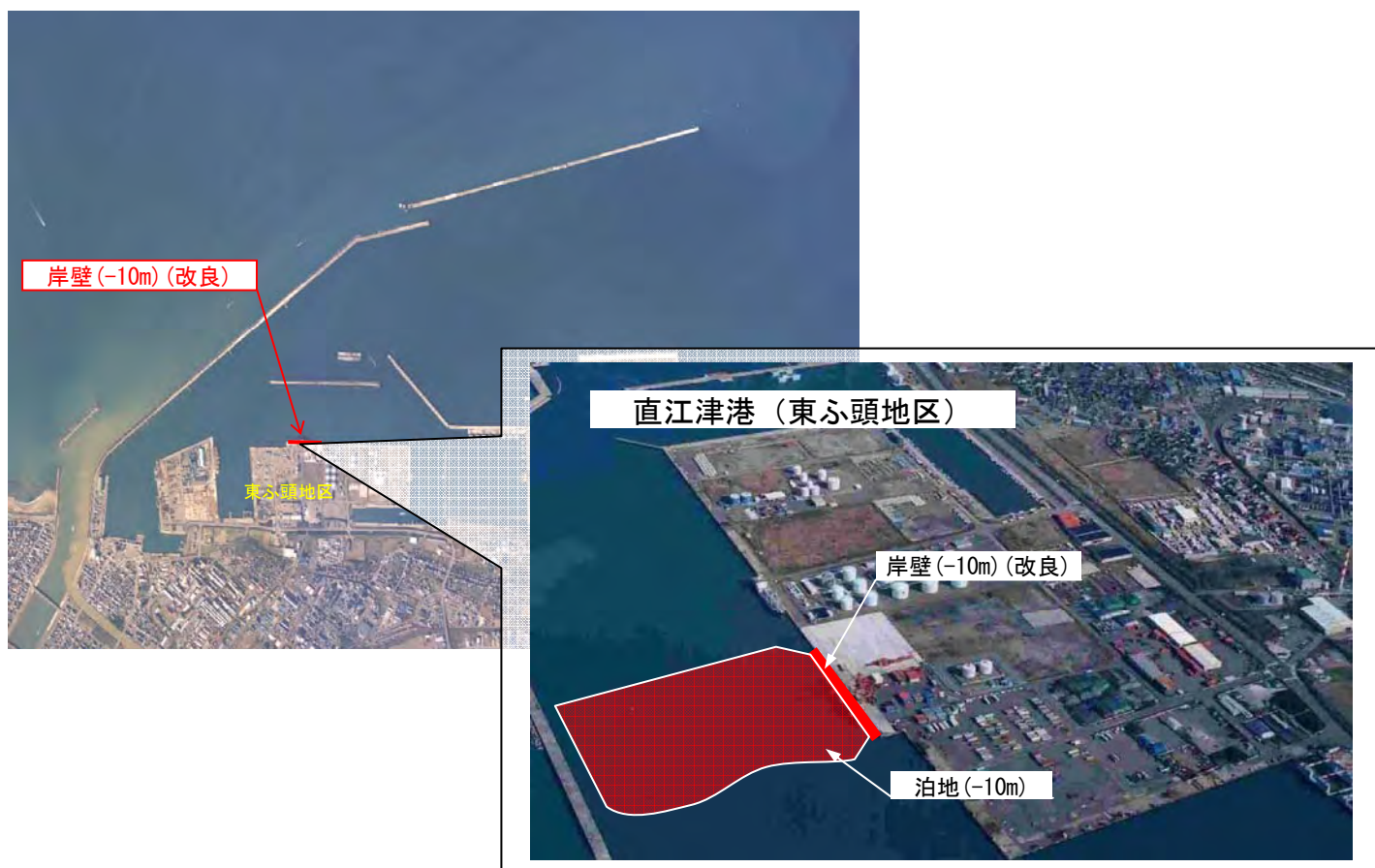
直江津港(東ふ頭地区)の現況
