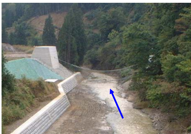
完成した竜光砂防捕捉工
