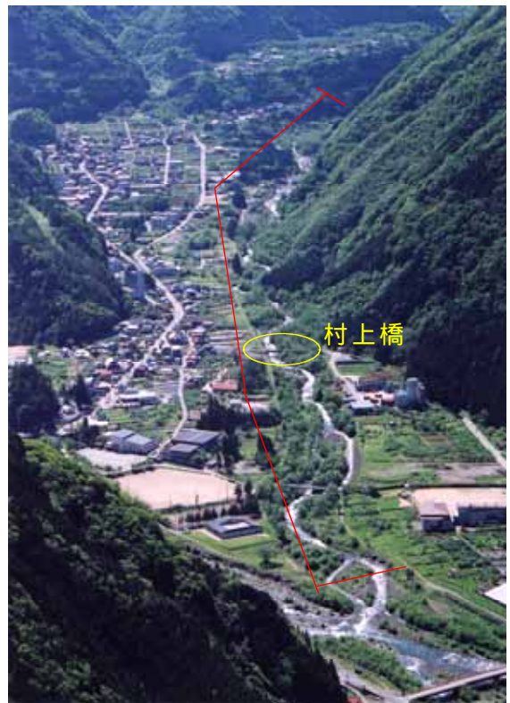
平湯川樹林帯計画箇所
