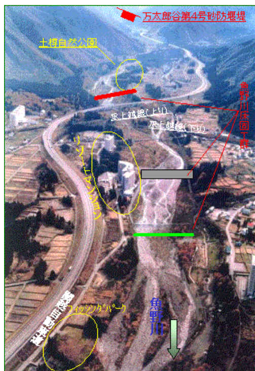
魚野川床固工群(土樽地区)
