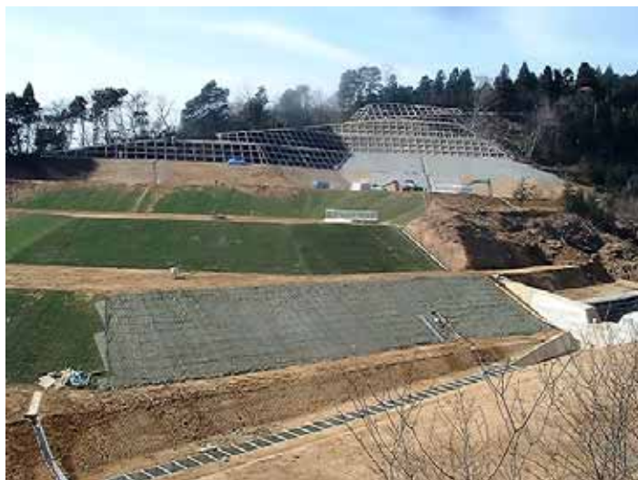
災害関連緊急地すべり対策事業が進む谷屋地区
