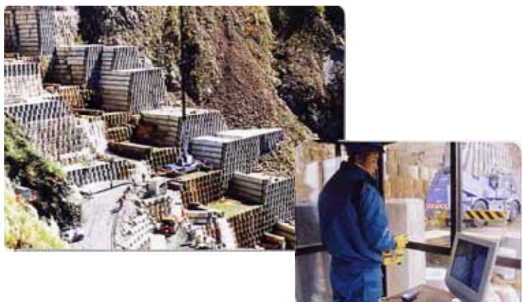
大型無人クレーンの作業状況
