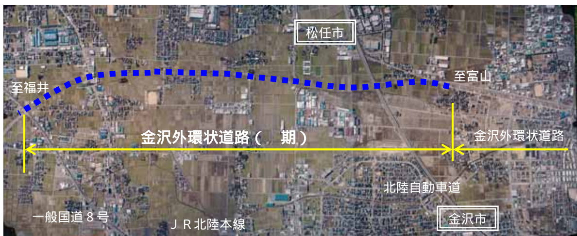
上空より金沢外環状道路( 期 )の事業区間を望む
