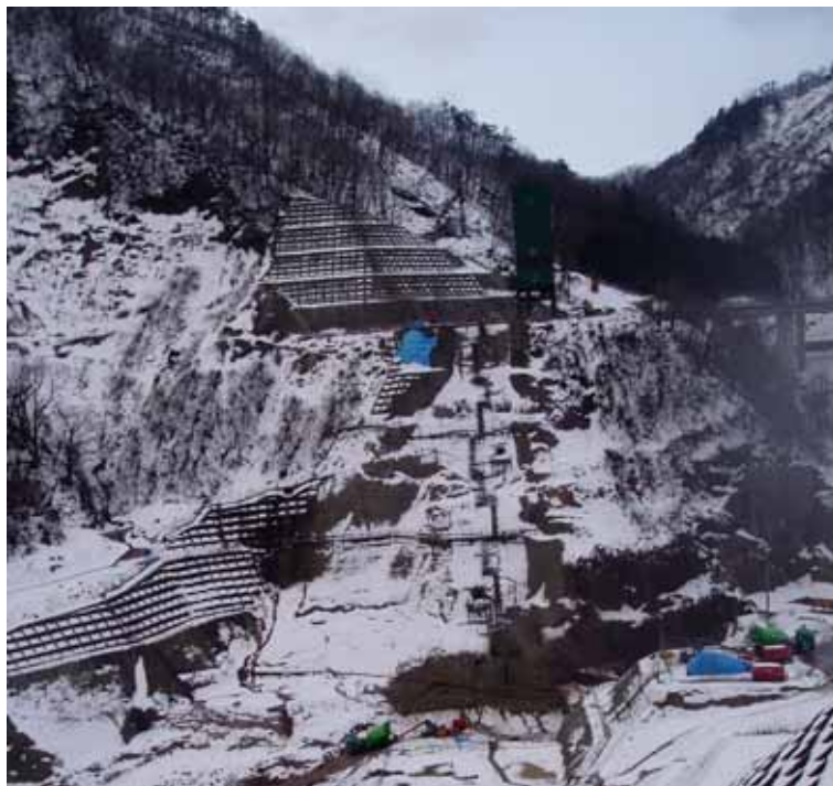
基礎掘削の概成した横川ダムサイト (右岸から左岸を望む：平成 15 年 12 月撮影)
