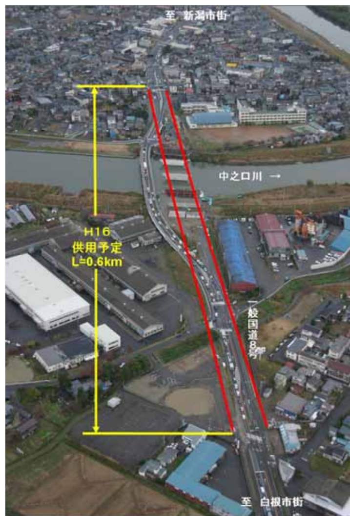
平成 16 年度供用に向け工事の進む大野大橋 (白根方向から新潟方向を望む)
