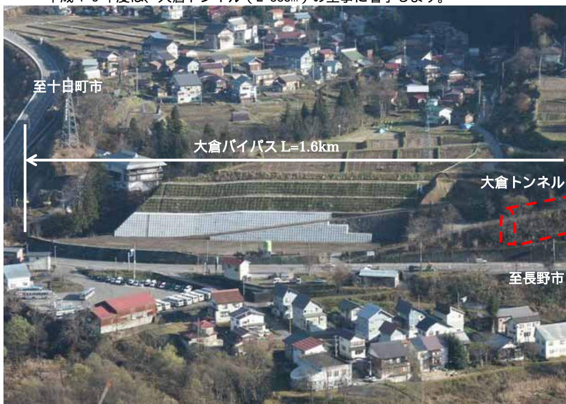
終点側トンネル坑口（十日町市側）を望む
