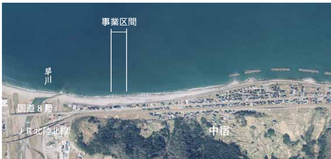
事業箇所（平成 11 年 4 月撮影）
