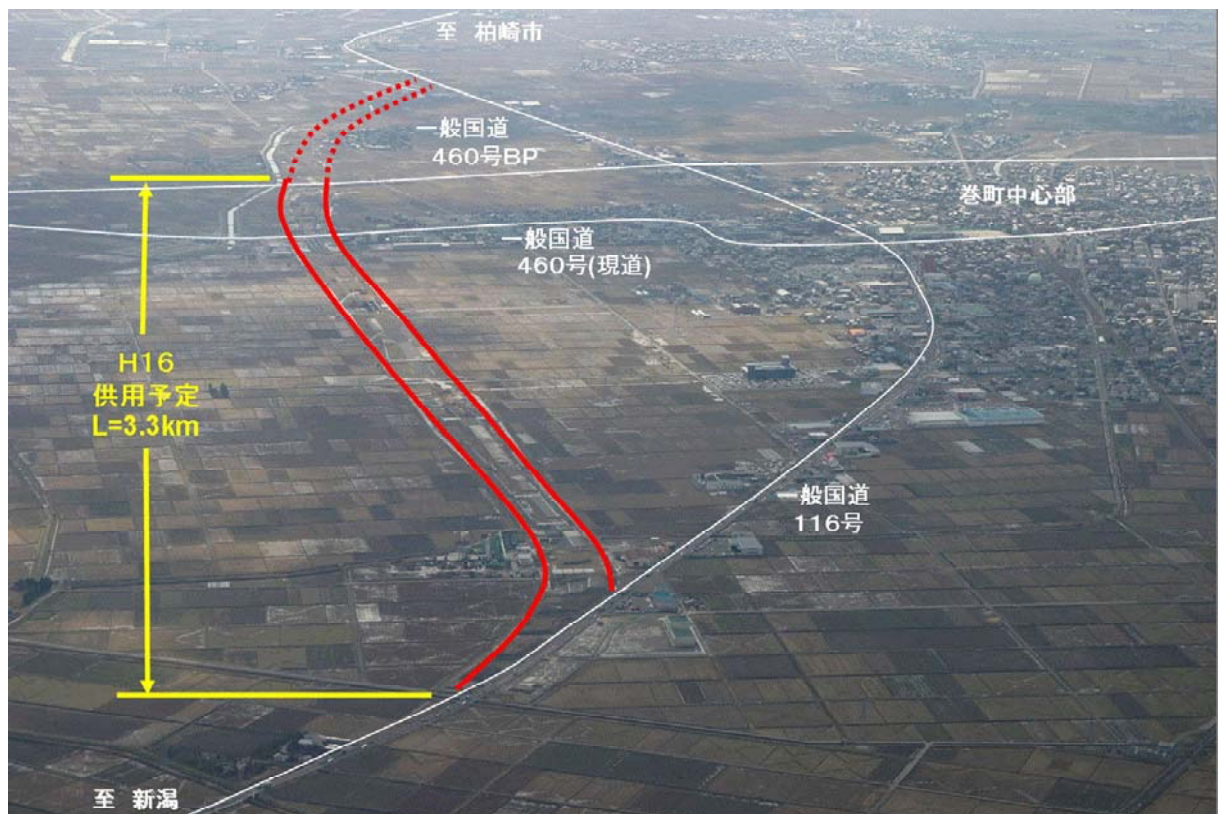
平成16年度供用に向け工事の進む巻バイパス (新潟方向から柏崎方向を望む)
