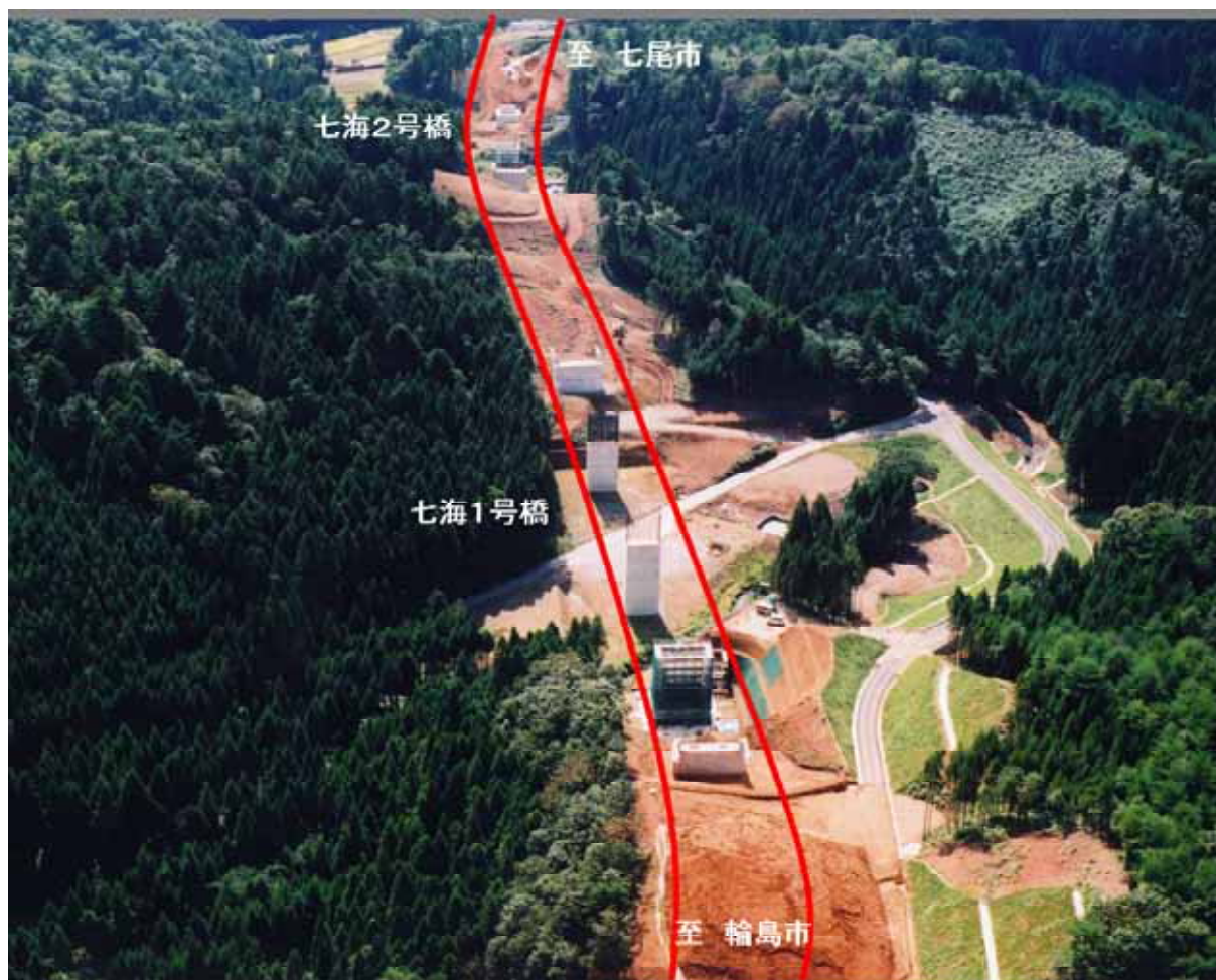
早期供用に向け工事の進む穴水道路 (輪島方向から金沢方向を望む)
