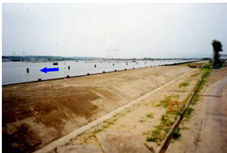
金沢市湊地先築堤の施工状況(平成15年7月撮影)
