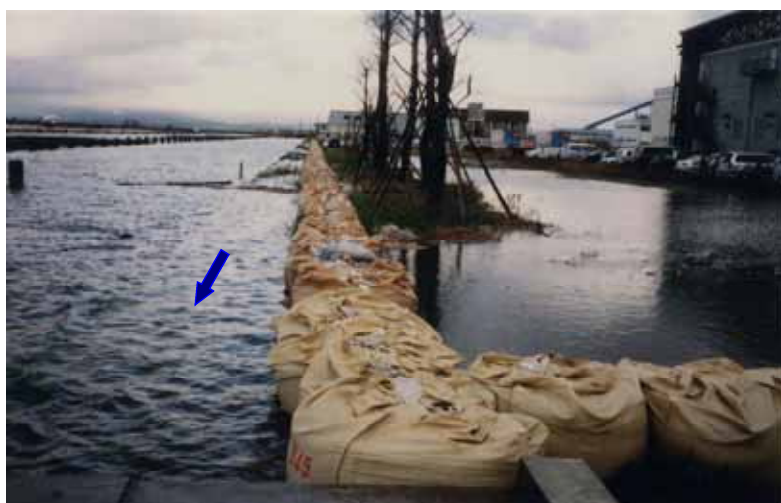
平成10年9月22日出水による浸水状況(金沢市湊地先)
