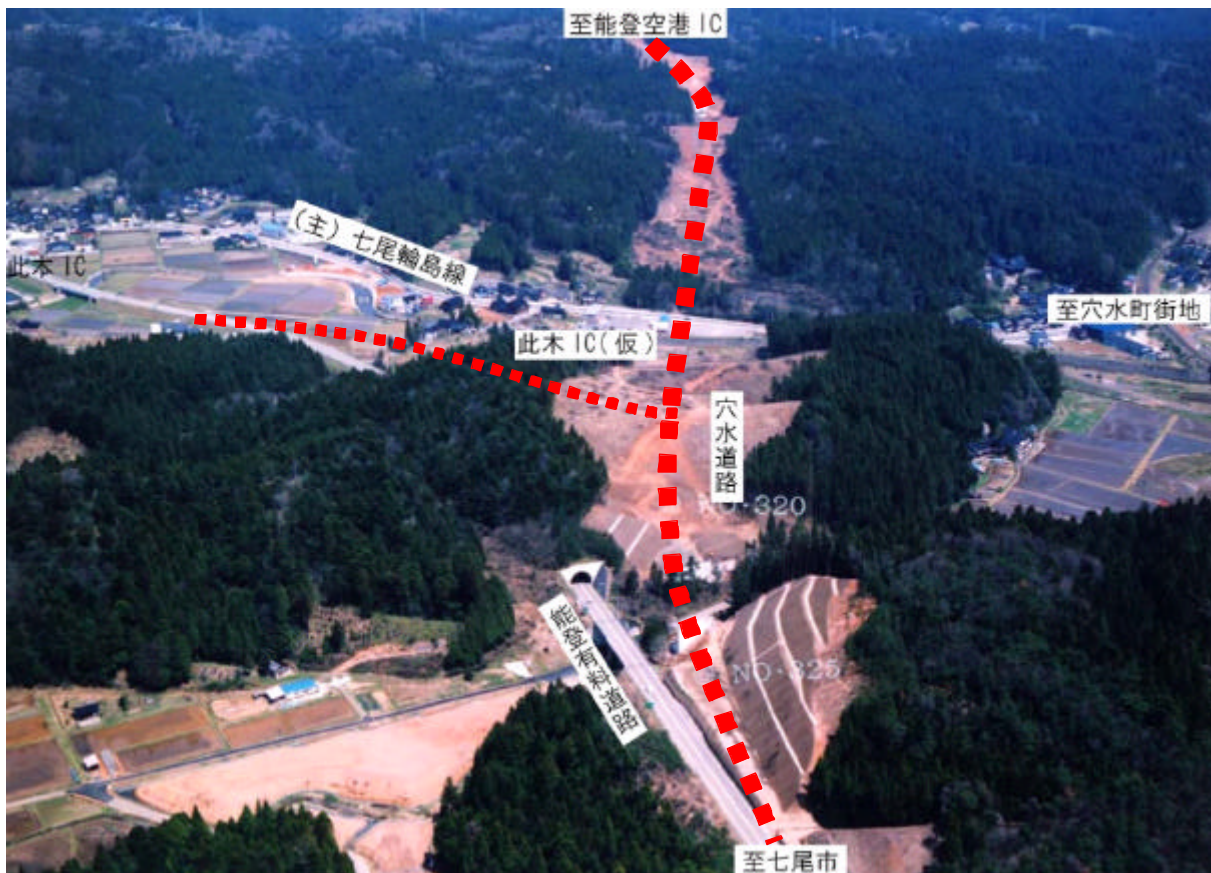
工事推進中の穴水道路此木IC周辺
