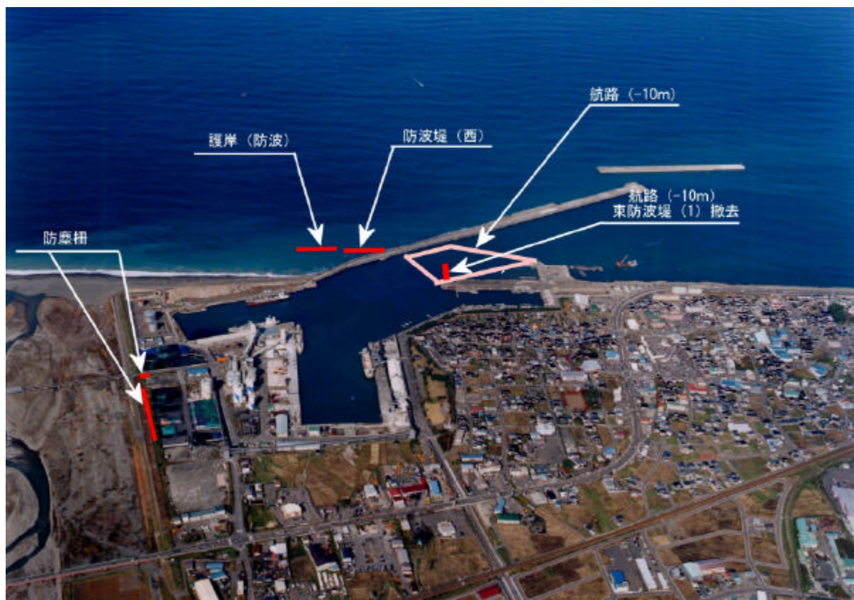
姫川港の現況 (平成13年11月撮影)
