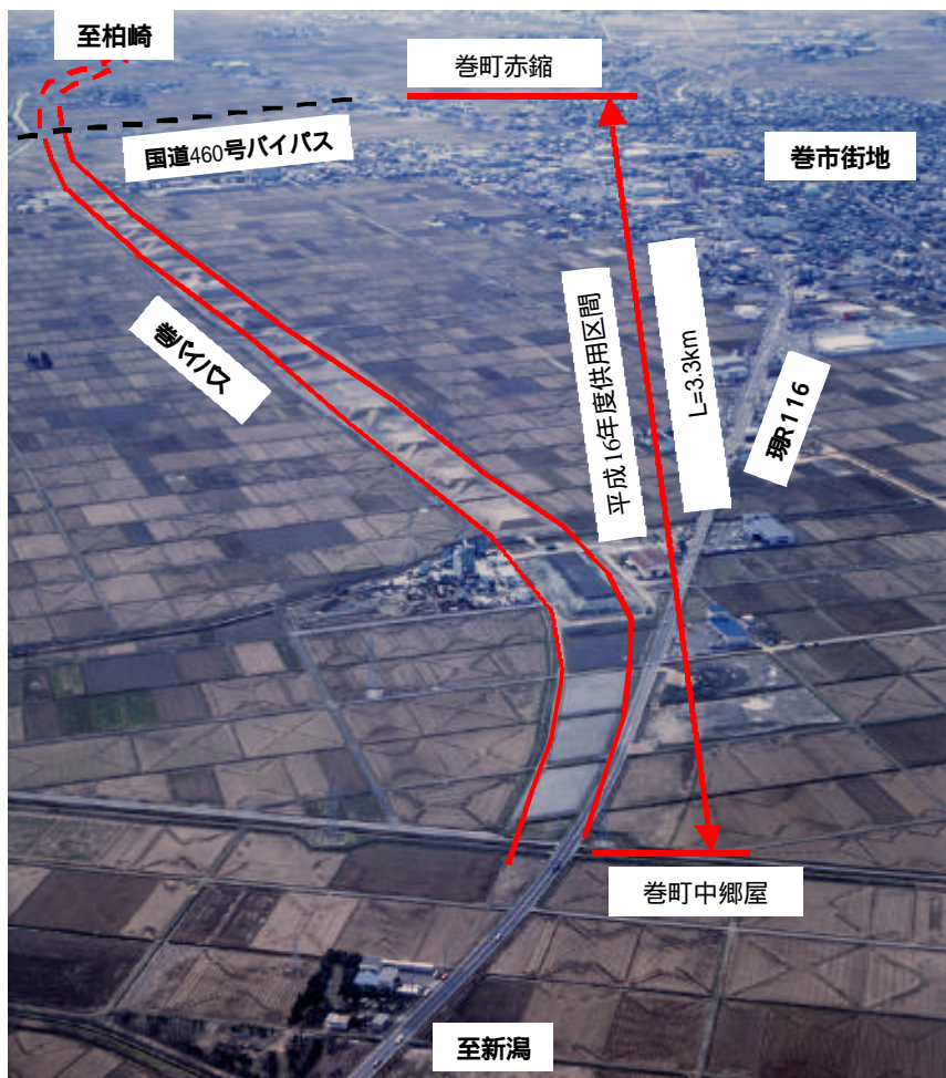
工事推進中の巻バイパス中郷屋周辺
