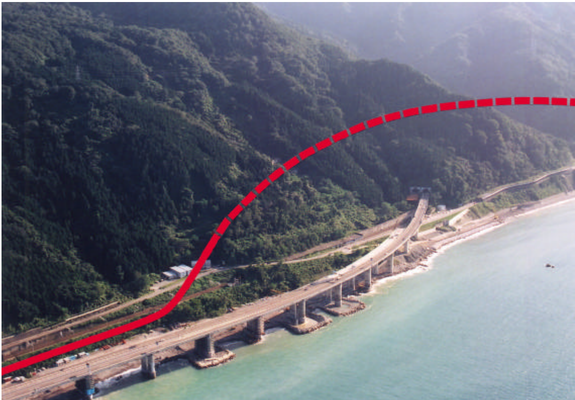
危険箇所を迂回する別線ルート（風波第一トンネル）
