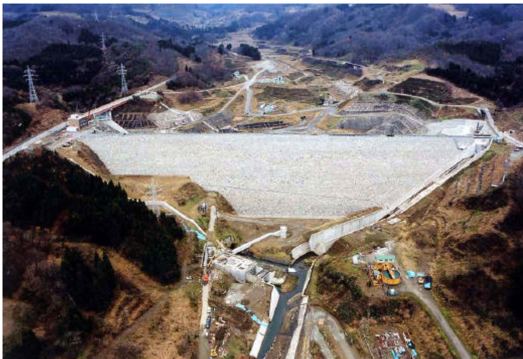
本体施工箇所付近（下流側より望む H13.12 撮影）
