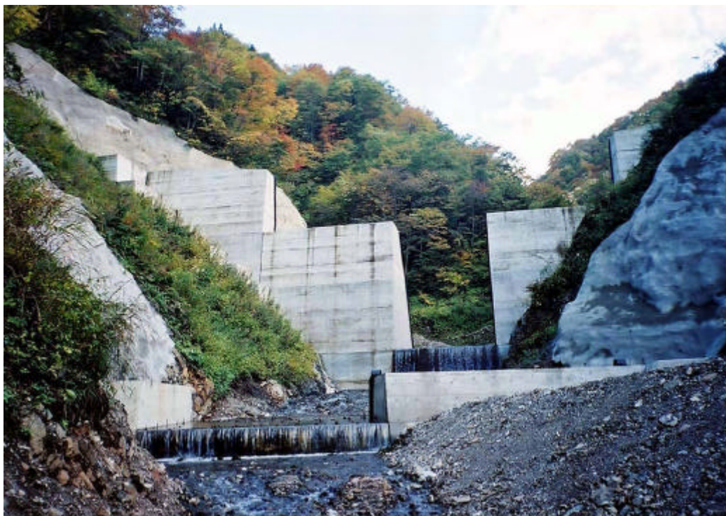
工事が進む6号砂防堰堤（下流側より望む H13.10撮影）
