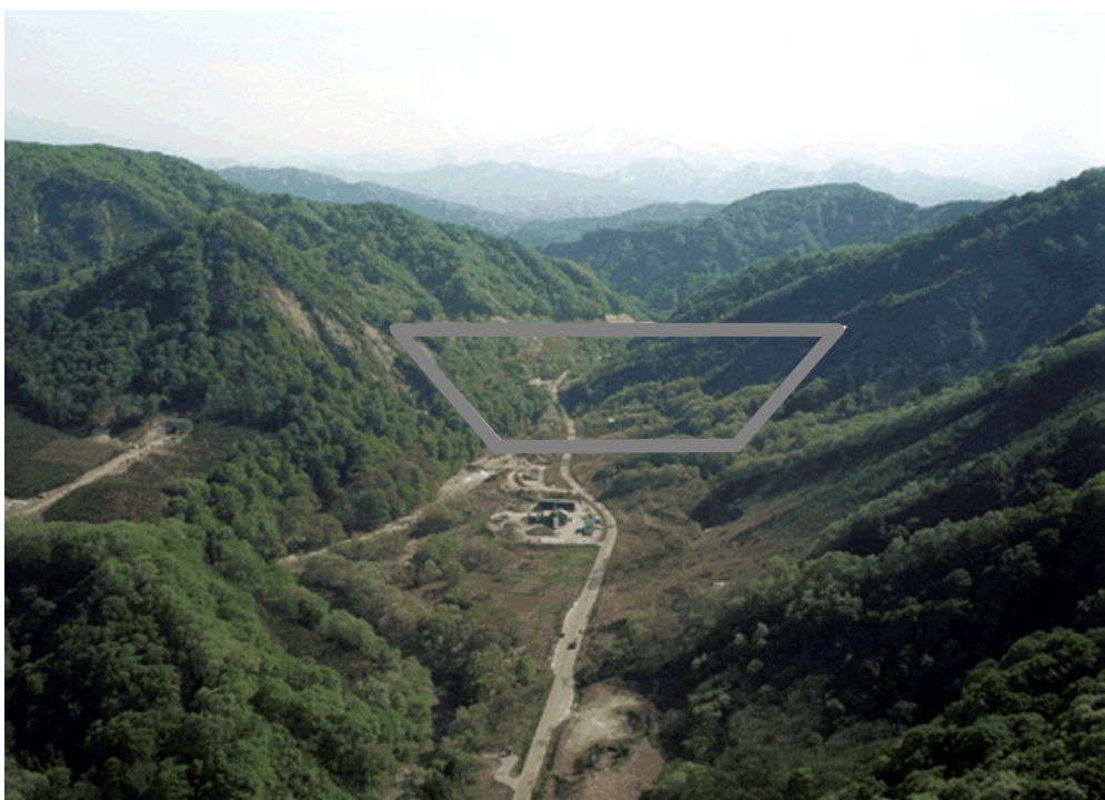
本体施工箇所付近（下流側より望む H13.5 撮影）
