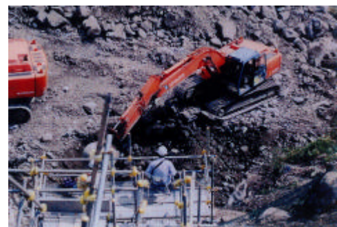
遠隔操作による掘削状況
