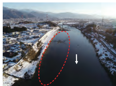
立ヶ花狭窄部の河道掘削状況（令和3年12月）
