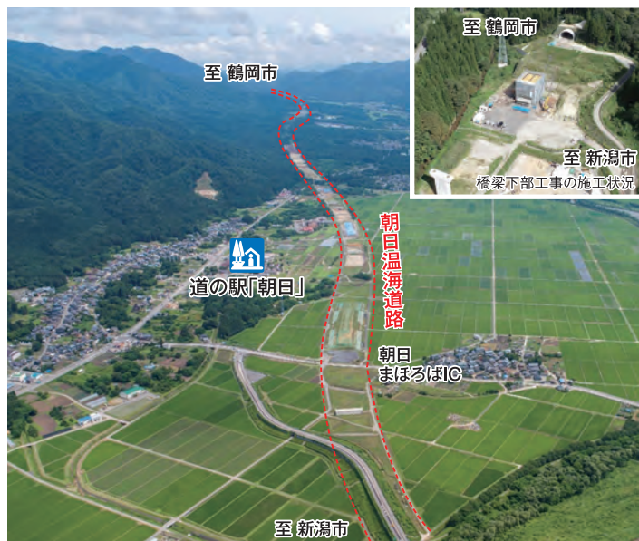
高速ネットワーク形成による高規格道路のミッシングリンク解消を目的とした朝日温海道路（新潟県村上市）
