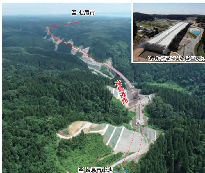
高速ネットワーク形成による能登半島の発展、観光の活性化などを目的とした輪島道路（石川県輪島市）
