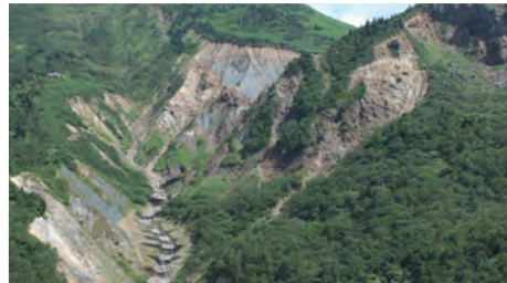
荒廃の著しい白山から下流域を守り続ける基之助谷砂防堰堤群 (石川県白山市)
