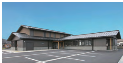
下越森林管理署村上支署 (新潟県村上市)
