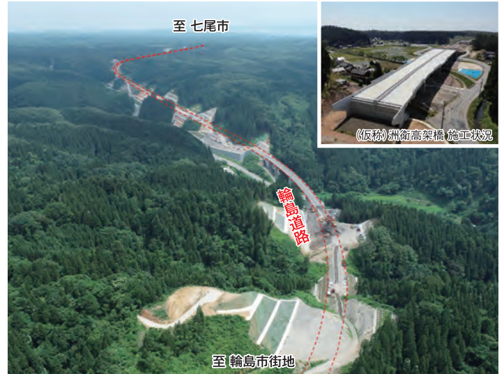
高速ネットワーク形成による能登半島の発展、観光の活性化などを目的とした輪島道路（石川県輪島市）
