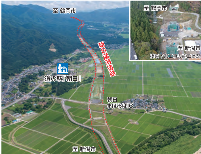
高速ネットワーク形成による高規格道路のミッシングリンク解消を目的とした朝日温海道路（新潟県上市）
