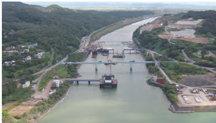
令和の大改修 大河津分水路（国）
