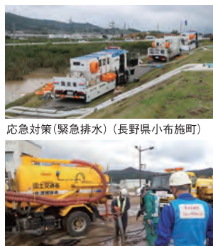
応急対策(路面堆積土砂撤去)（長野県長野市）
