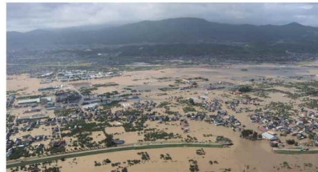
令和元年東日本台風による豪雨に伴う千曲川の堤防決壊 (長野県長野市穂保)
