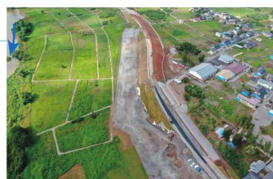
堤防復旧完了状況(令和2年6月20日)
