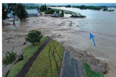
堤防決壊状況(令和元年10月13日)
