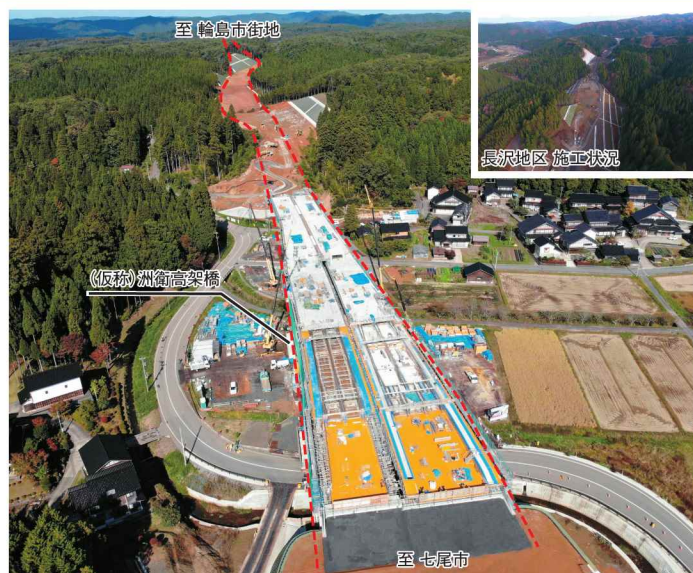
高速ネットワーク形式による能登半島地域の発展、観光の活性化などを目的とした輪島道路（石川県輪島市）
