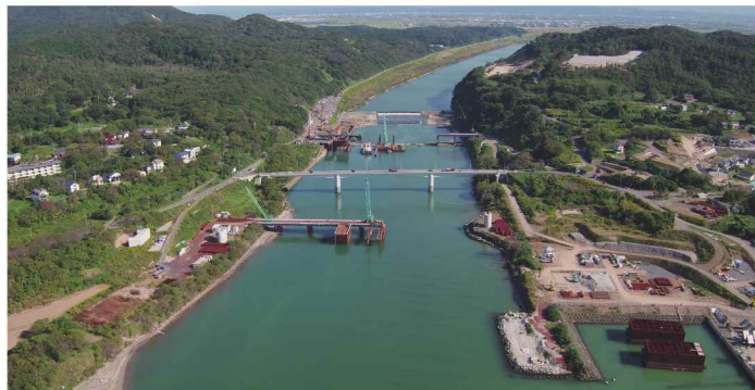
令和の大改修 大河津分水路(国)
