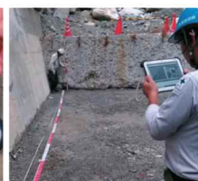
環境タブレットによる 出来形測定撮影状況
