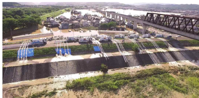
排水ポンプ車・照明車による緊急排水(平成30年7月豪雨)
