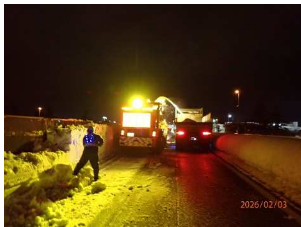
図-1 長岡IC閉鎖による集中除雪状況 (2026年2月3日実施)
