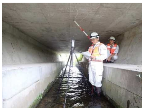
図-7 点検の様子
