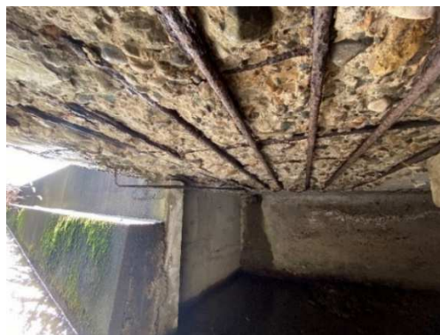
図-5 減肉を伴う局部的でない鉄筋露出
