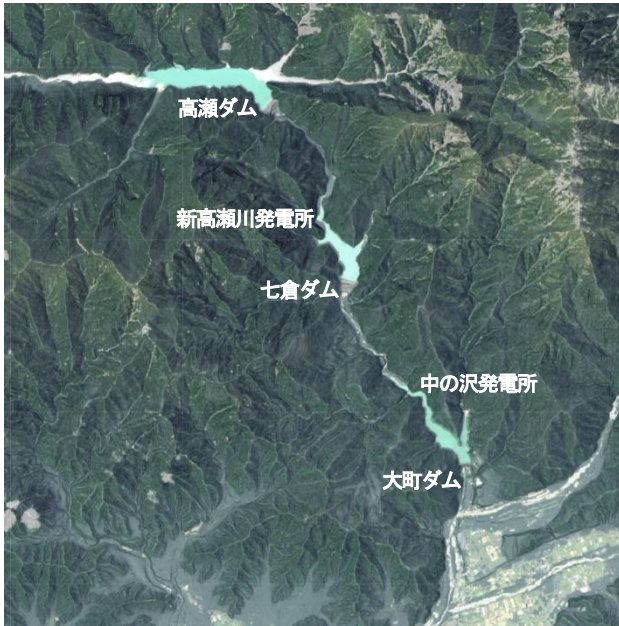
写真-1 高瀬渓谷にある3ダム（国土地理院より）
