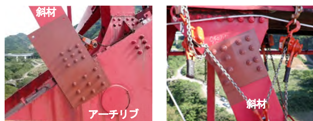
写真-4 鋼板による固定状況（左：下側 右：上側）
