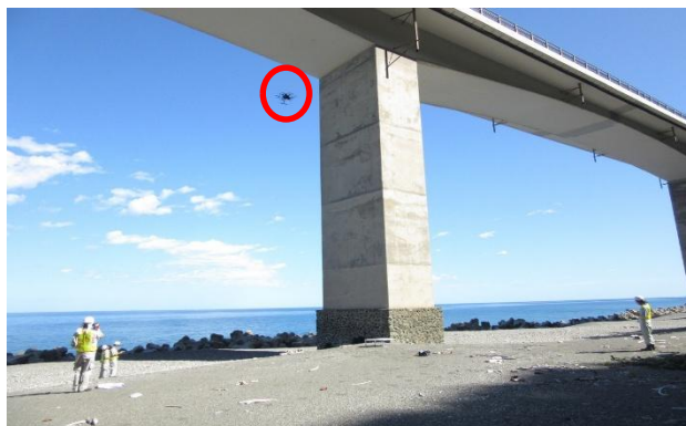
写真-5 高橋脚のドローン点検の様子
