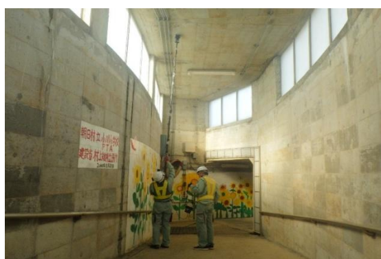
写真-4 高所の打音検査
