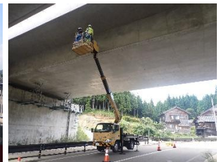
写真-2 高所作業車
