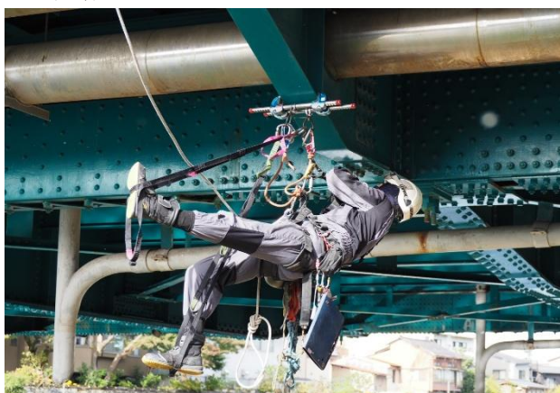
写真-6 特殊高所技術による点検の様子
