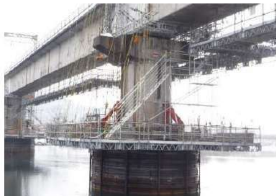
写真-2 仮設STEP（例）
