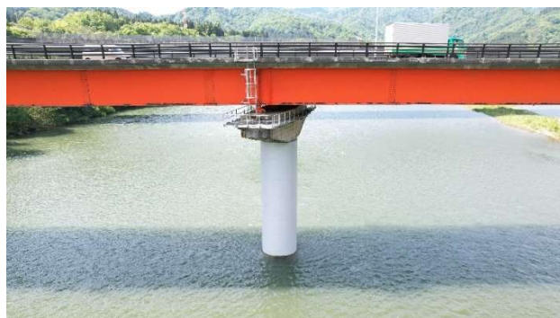
図-9 工事完了（P2橋脚）
