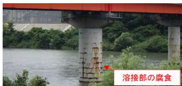
写真-3 P3橋脚の状況 (2024年度目視結果)
