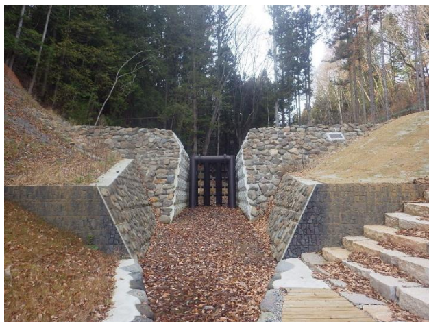
写真-5 透過型砂防堰堤(R7. 12)
