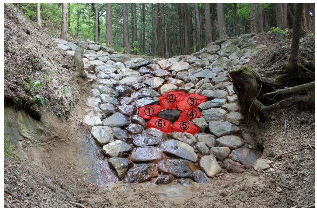
写真-1 4号石積堰堤
