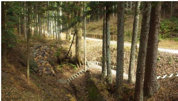
写真-8 石積堰堤までのアプローチ路
