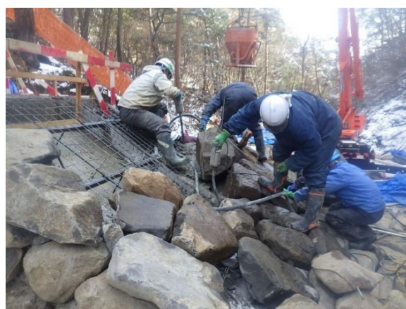
写真-3 補強堰堤石張りの様子
