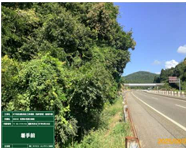
写真-1 支障木による標識視認性不良
