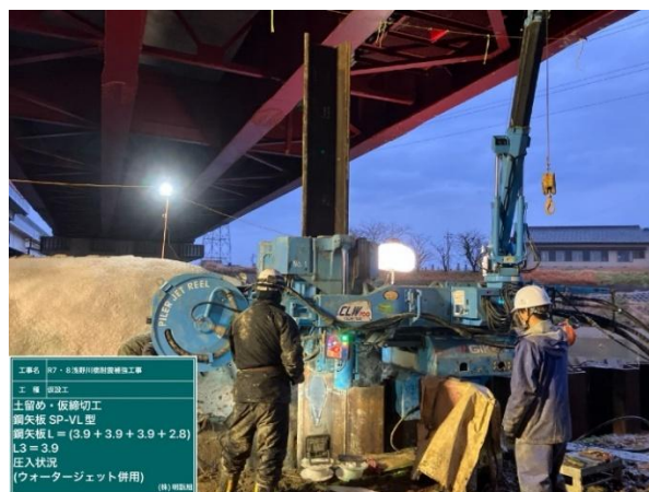
写真-3 上部障害クリア工法による施工状況
