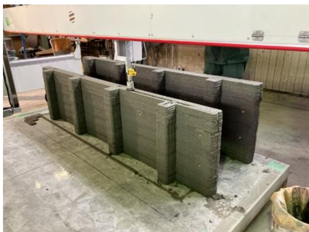
写真4 3Dプリンターによる工場製作状況
