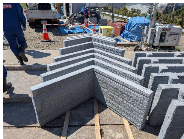
写真-1 3Dプリンターで作成した型枠
