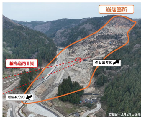
写真-1 起点側坑口部周辺の被災状況
