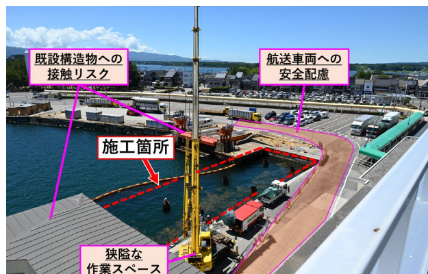
図-8 4号岸壁：施工箇所の写真
