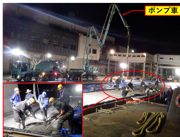
図-15 ポンプ車による舗装コンクリート打設・人力均し
