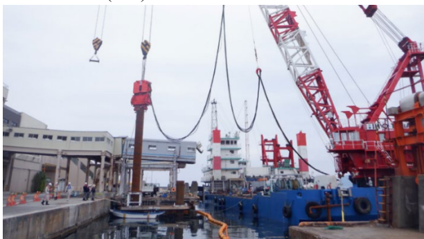
図-6 鋼管杭打設
