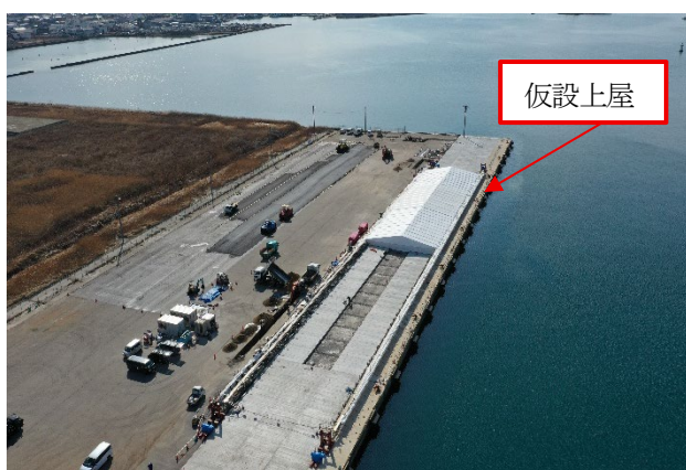
図-9 仮設上屋の設置状況
