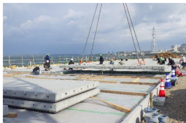
図-11 プレキャスト舗装版の据付状況
