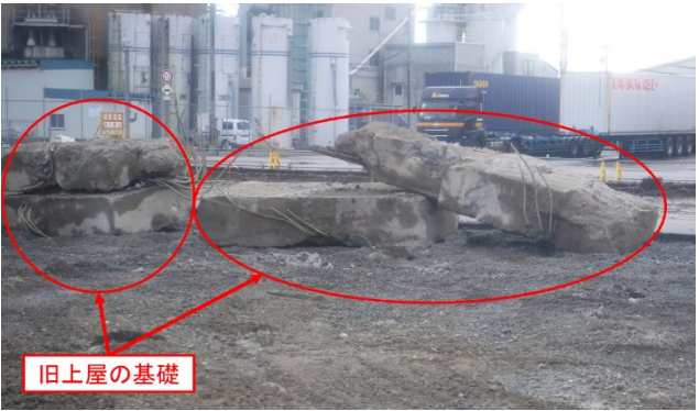
図-7 支障物（旧上屋の基礎）
