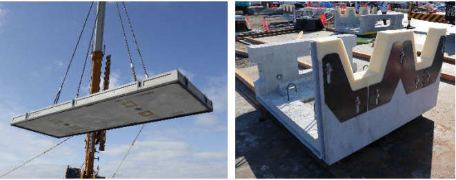
写真-5 左：舗装版、右：上部工
