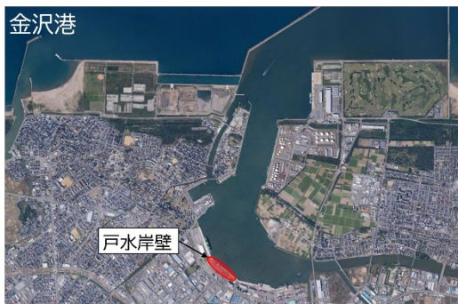
図-1 金沢港 戸水岸壁
