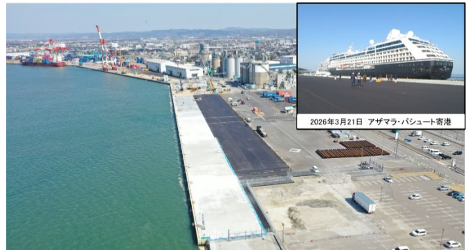
写真-8 復旧完了
