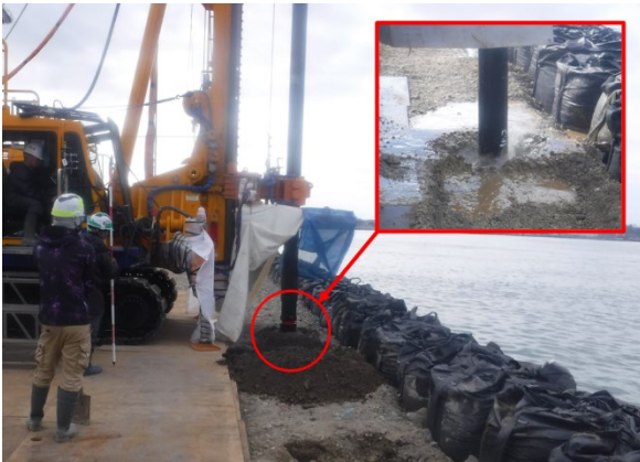
図-9 小型機での地盤改良
