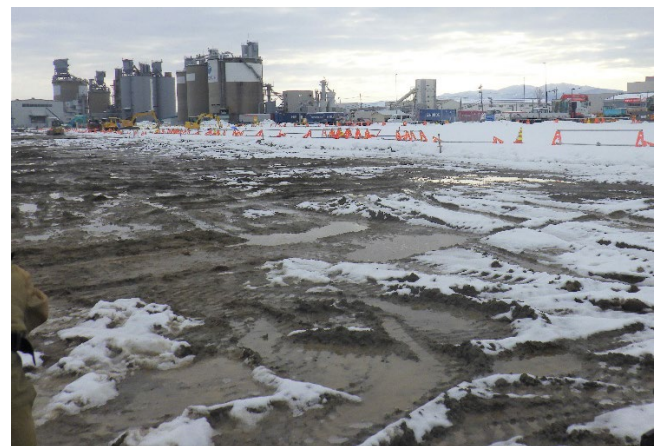
写真-3 路床部 除雪状況
