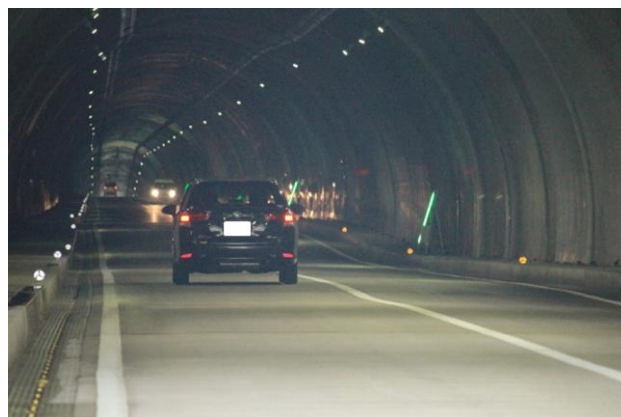
写真-11-1 2車線通行確保状況
