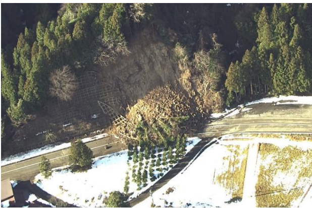
写真2 斜面崩落状況
