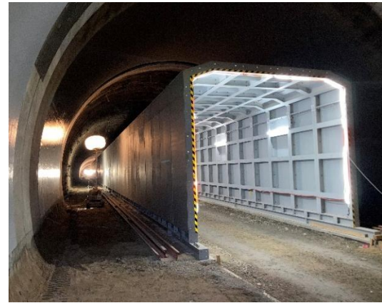
写真-5 プロテクター設置状況
