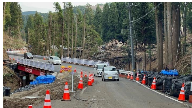
写真-8 迂回路による1車線通行確保状況
