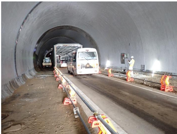
写真6 トンネルプロテクター内試走状況
