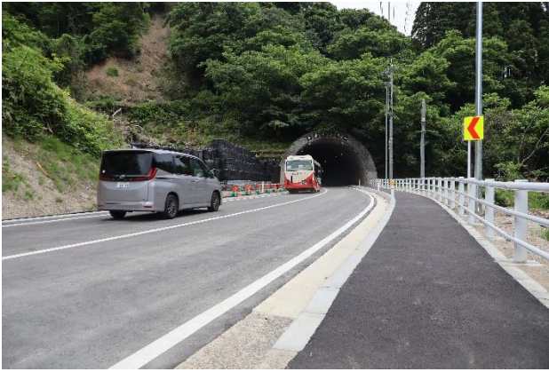
写真-11-1 2車線通行確保状況
