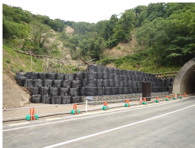
写真-10 輪島市街地側坑口部の待ち受け対策状況
