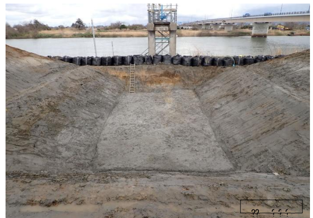
(図－18 二次掘削状況 )
