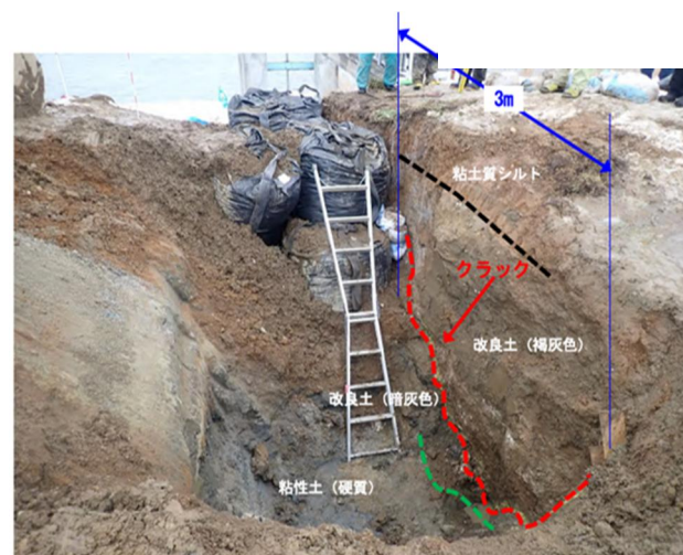
(図-10 川表開削状況)
