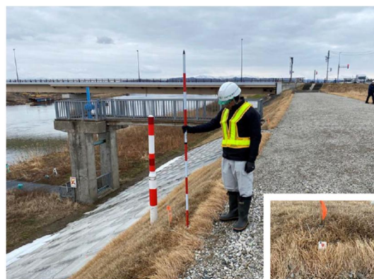
（図－２２ モニタリング用測量杭設置）
