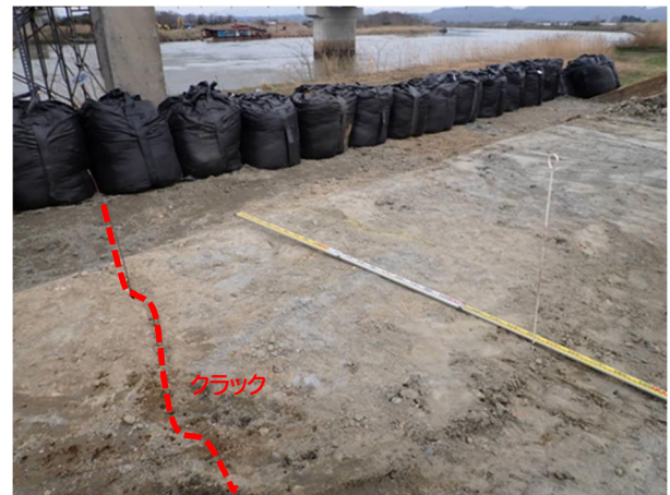
(図－17 一次掘削状況 )
