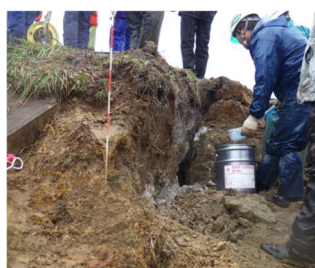
(図-8 石灰水注入の様子)
