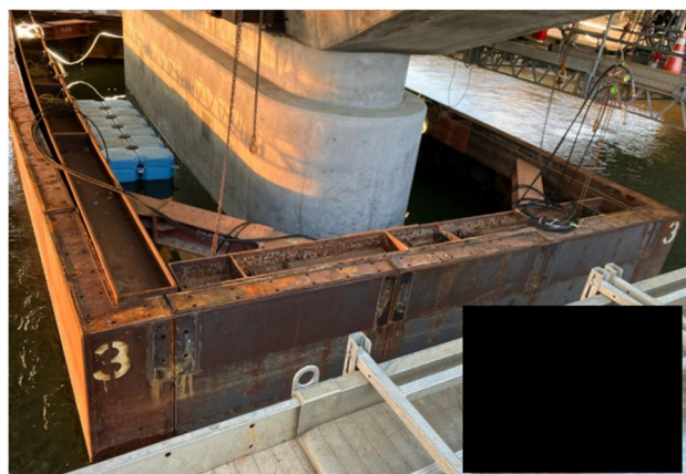
写真-6 STEP工法
