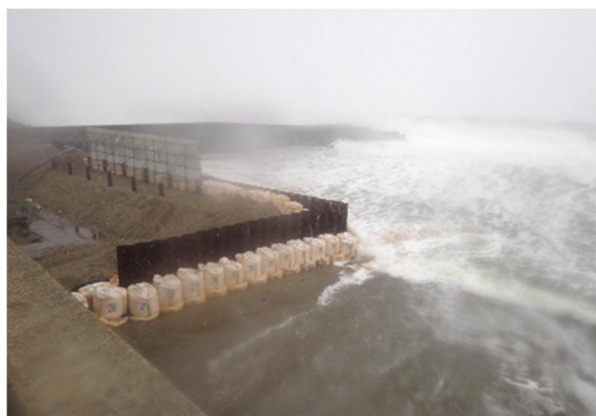
写真-3 波浪状況(P1橋脚)
