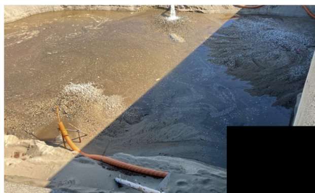
写真-8 掘削土砂排出状況
