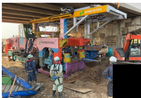
写真-5 鋼矢板打設地盤の砂置換え(P2橋脚)
