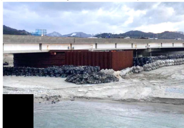
写真-4 波浪状況(P2橋脚)
