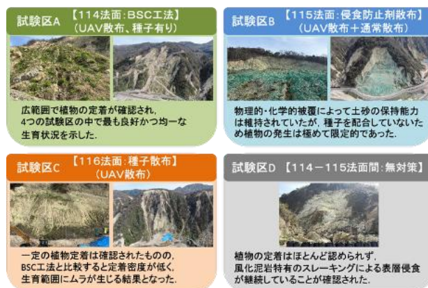
図-8 各工法の植生定着状況比較(施工約半年後)
