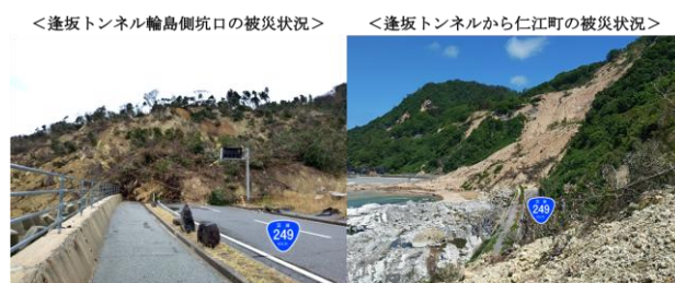
図-2 逢坂トンネル前後の被災状況
