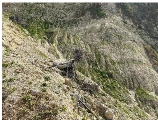
図-9 ガリ(侵食溝)部の植生の状況(試験区A:BSC工法)
