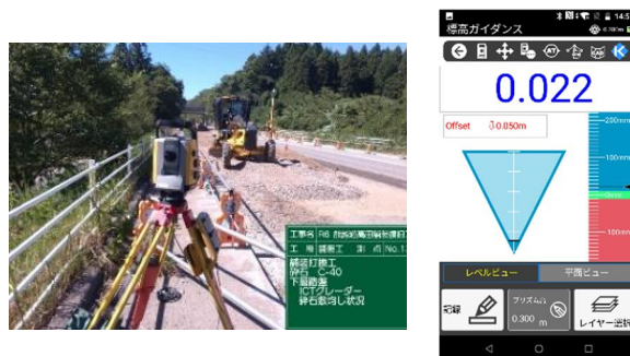
写真-4 三次元測器の活用（左：杭ナビ、右：快測ナビ）
