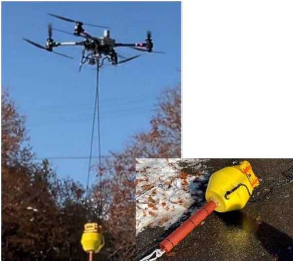
図-11 大型UAによる水位観測ブイ運搬・設置状況
