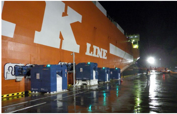
図-9 2024年度現地実証試験の様子
