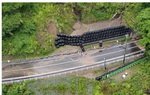
図-8 被災箇所詳細確認
