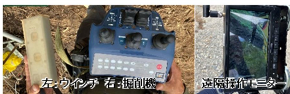
図-3 無人化掘削状況
