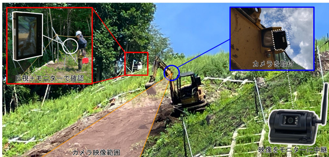
図-9 アームにカメラを設置したことにより安全な範囲からの無線操作を実現
