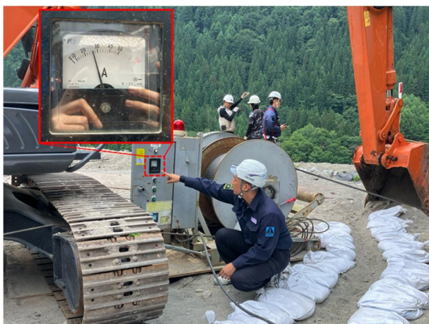
図-6 アンカー確認試験
