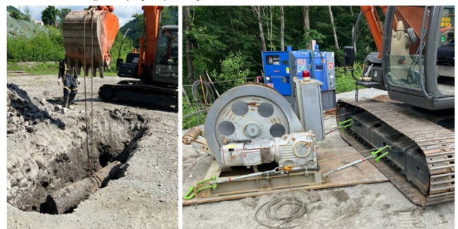
図-5 埋込アンカー・ウインチ設置状況
