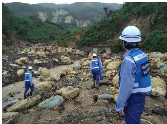
写真-3 広範囲に及ぶ被災箇所の状況
