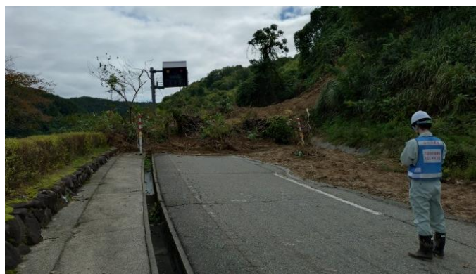
写真-4 現地調査が困難な土砂崩落箇所の例
