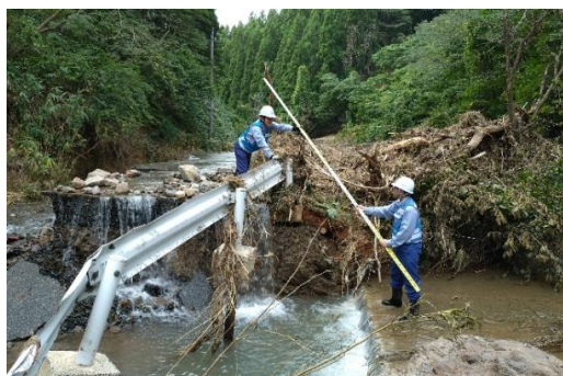
写真-1 TEC-FORCEによる被災状況調査の実施状況
