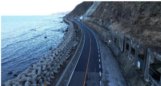
写真-1 工事箇所（長岡方面望む）
