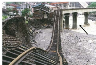
写真-3 上刈地区堤防決壊 写真-4 JR大糸線の被災状況
