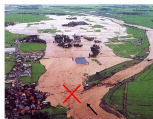
写真-2 月岡地区堤防決壊
