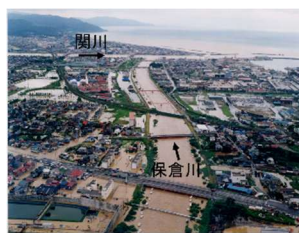
写真-1 下流部の浸水状況
